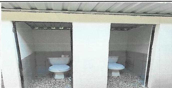
Foto 5: Remozamiento de baños, cambio de piso, techo, estructura, repello y azulejo.
