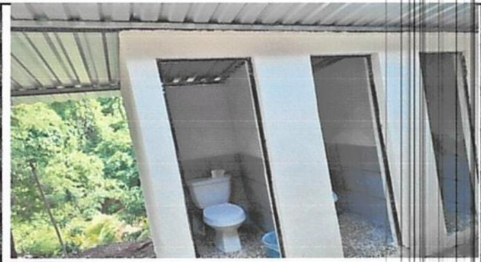
Foto 4: Remozamiento de baños, cambio de piso, techo, estructura, repello y azulejo.
